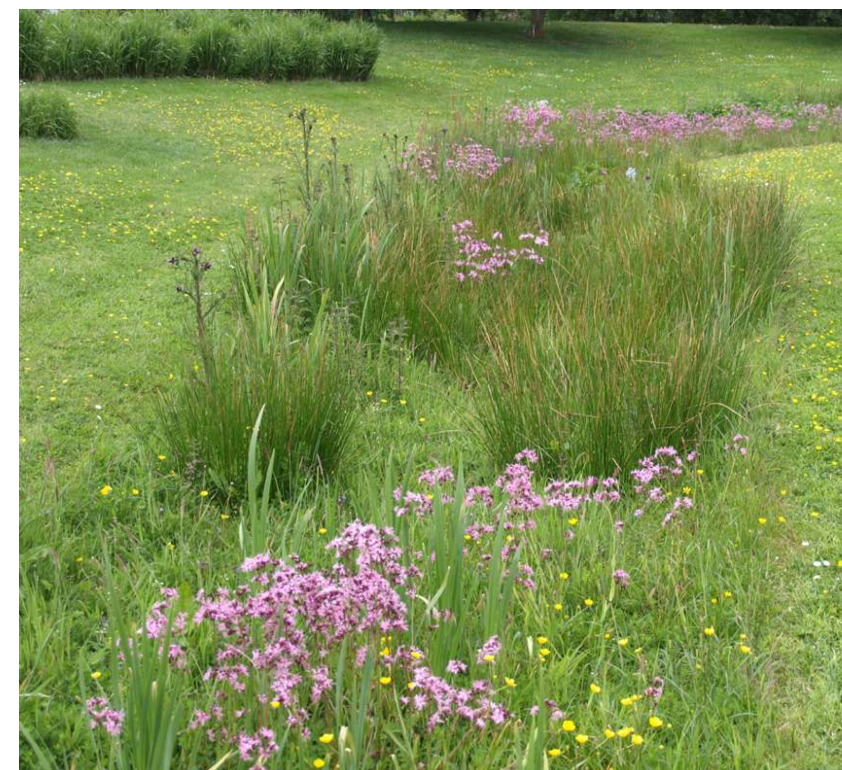
wadi; infiltratie hemelwater
